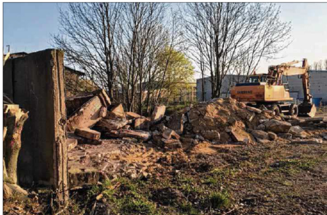
Der Bagger musste zunächst den schweren Betonteilen und anderen Baustoffen zu Leibe rücken. Foto: S. Wienbrock
